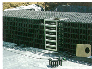
ステンレス製点検孔設置状態
