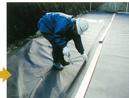
保護(透水)シート敷設
